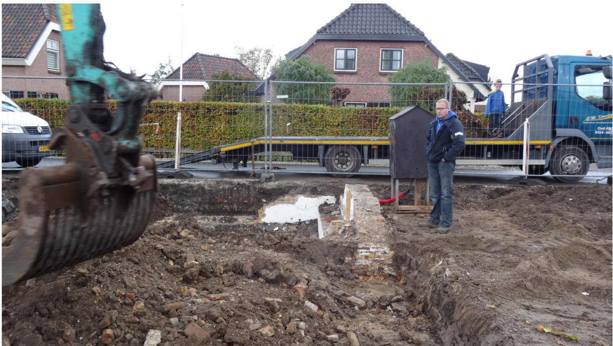
Afb. 16 Restant van de fundering onder de oostgevel met nog zichtbaar de aangestorte betonnen binnenbak ter hoogte van de kelder (witgepleisterd). Foto richting N.
